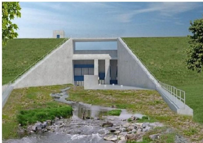
Výpust poldru bude průchodná pro migraci ryb. | foto: Povodí Labe
