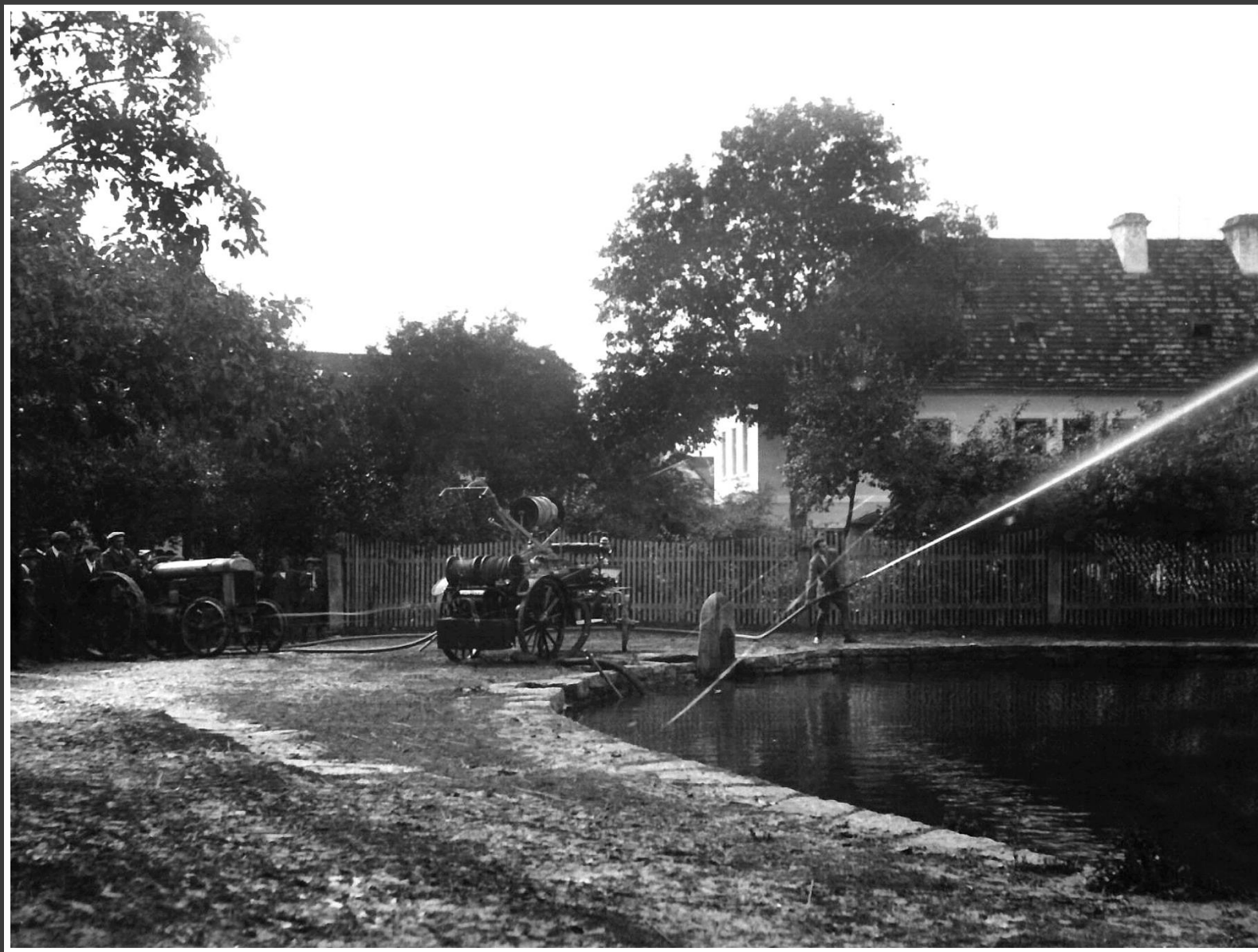
Kombinovaná stříkačka dle patentu bratrů Mervartových. Pohon traktorem FORDSSON.
