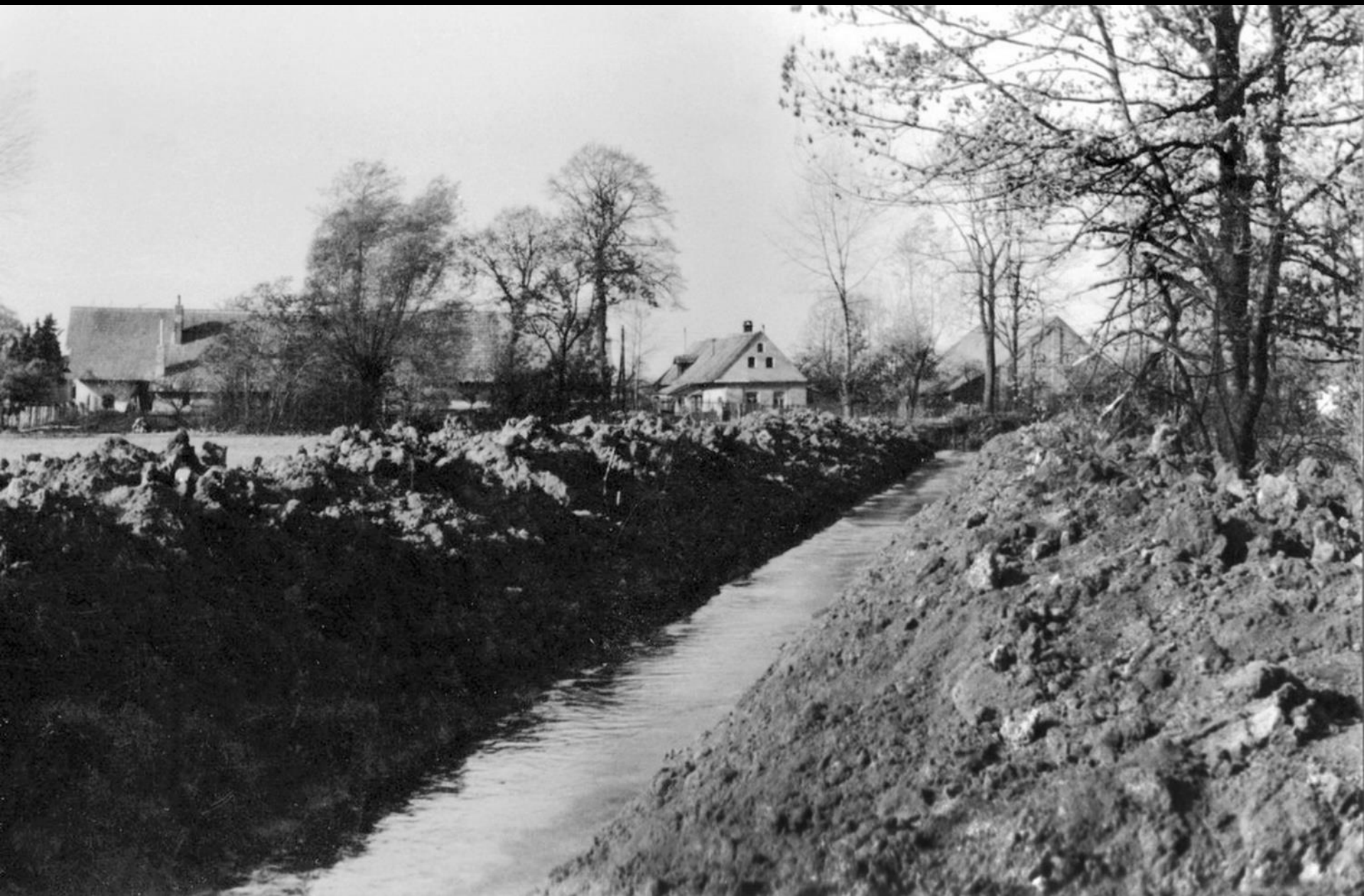
Další provizorní koryto kvůli stavbě mostu u Zemspolu
