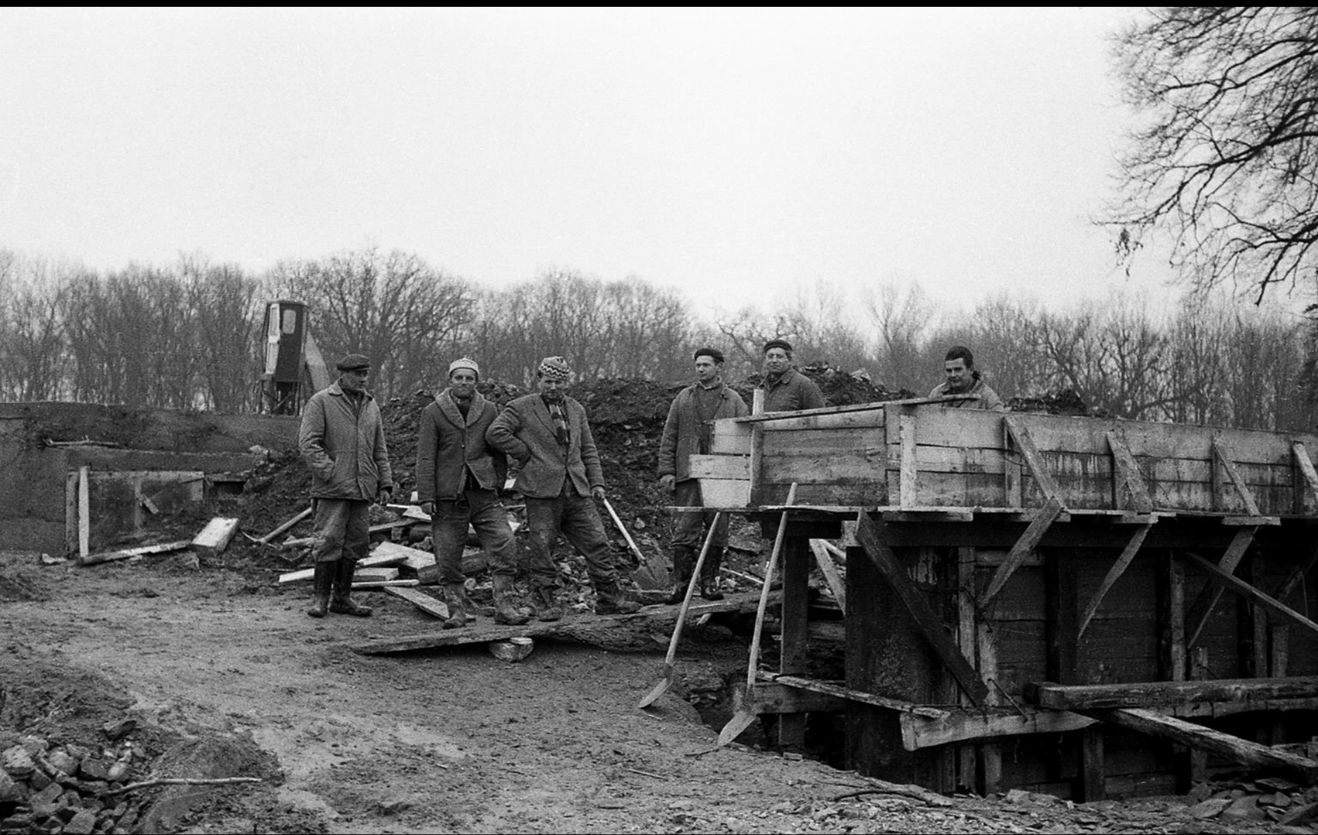
Stavba mostu u Vranova
