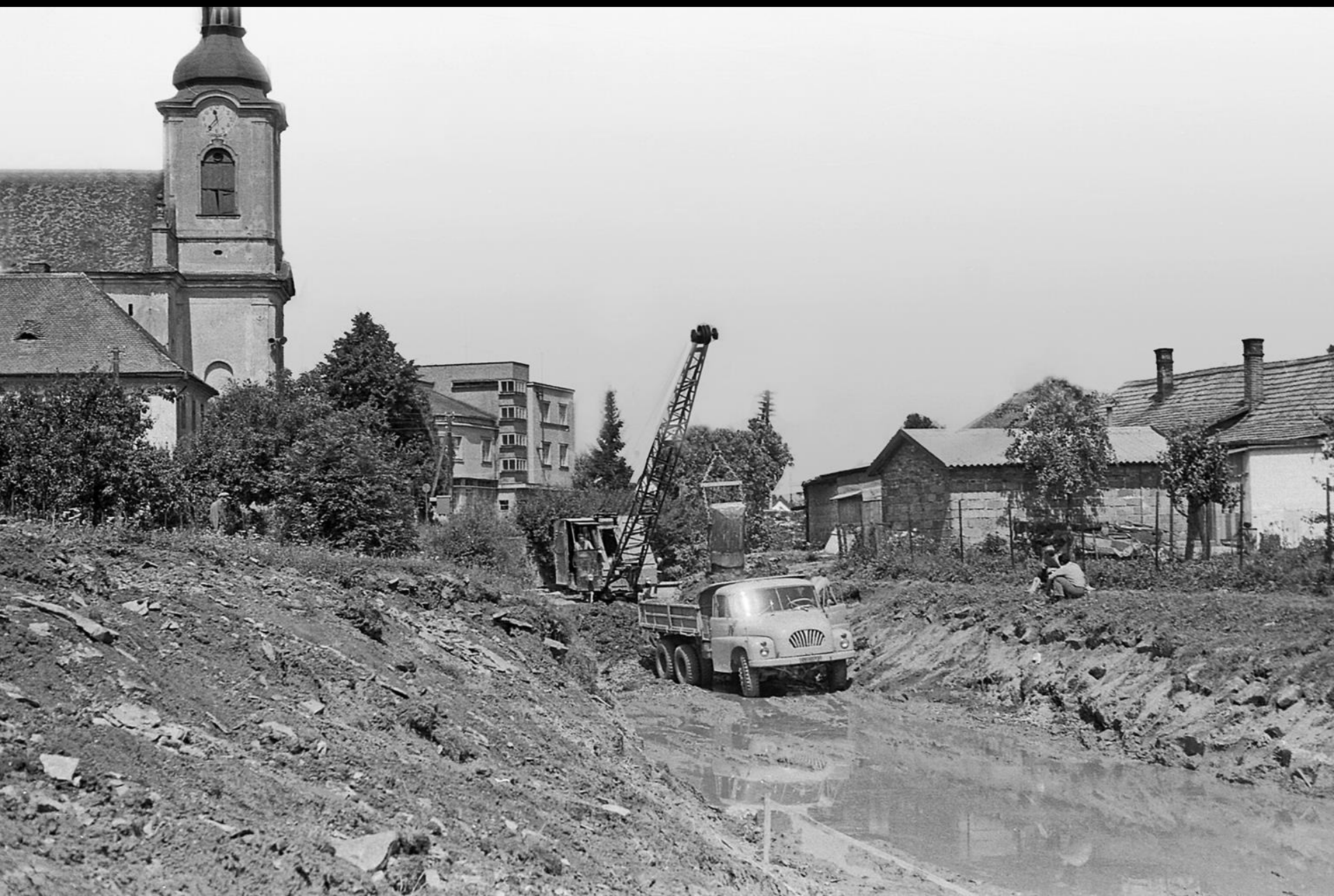
Koryto bylo prohloubeno řetězovým bagrem o více než metr
