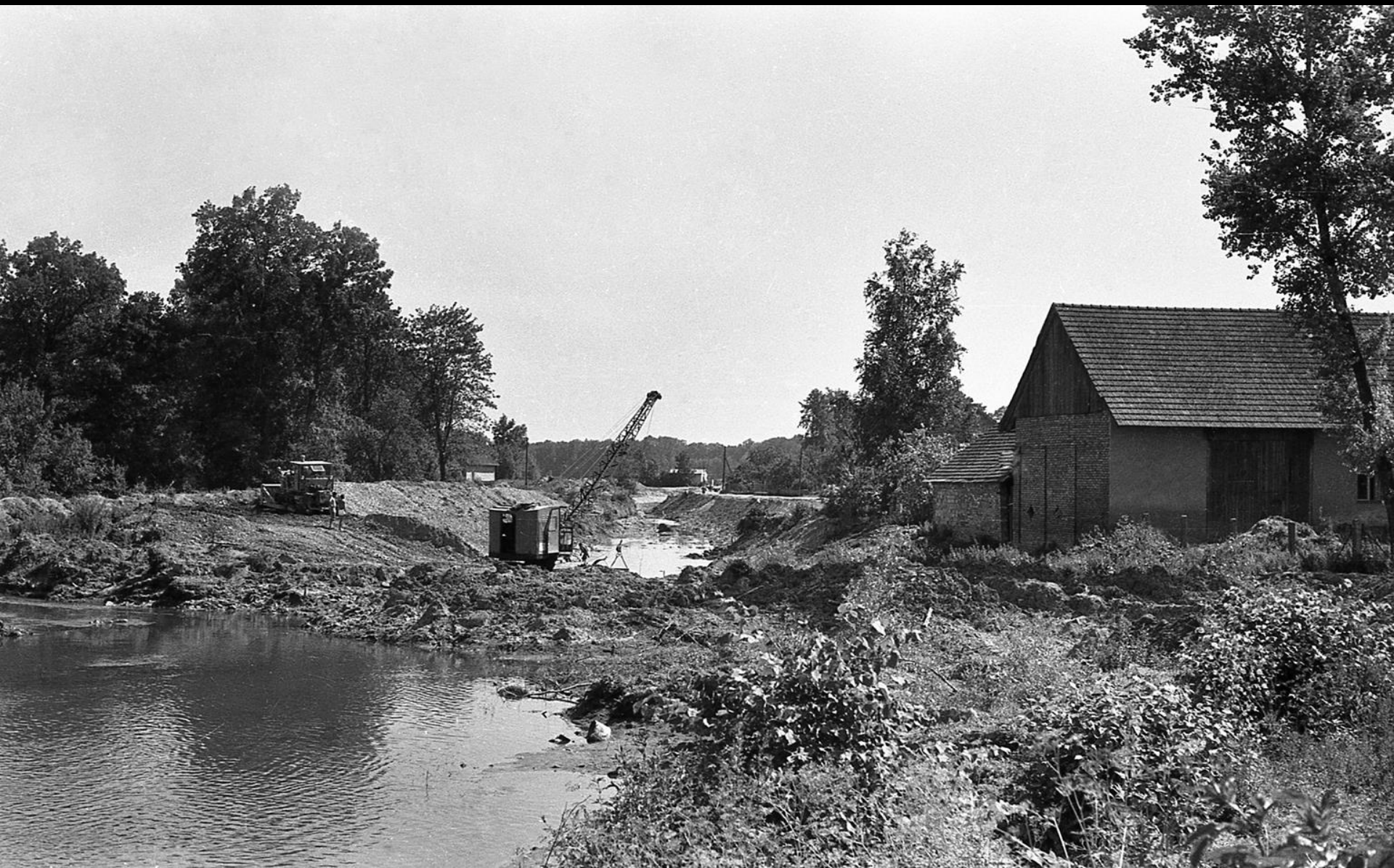
Původní koryto bylo přepaženo, tok byl veden dočasně vlevo (za buldozerem)
