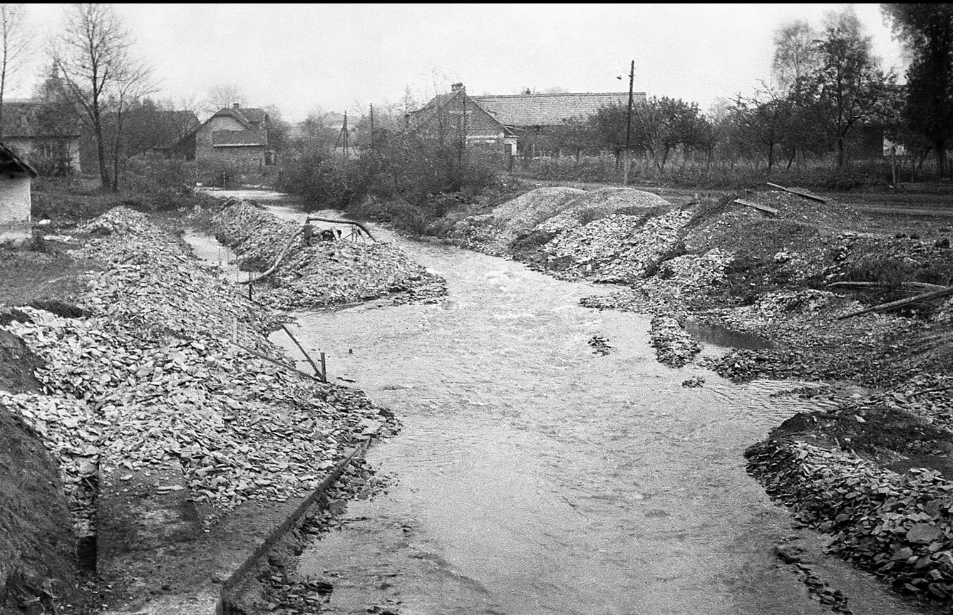
Na mnoha místech si dělníci pomáhali provizorním korytem a výkonným čerpadlem
