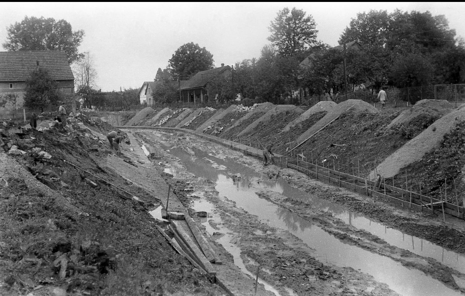
Zhotovení opěrného pásu pro betonové šestihrany
