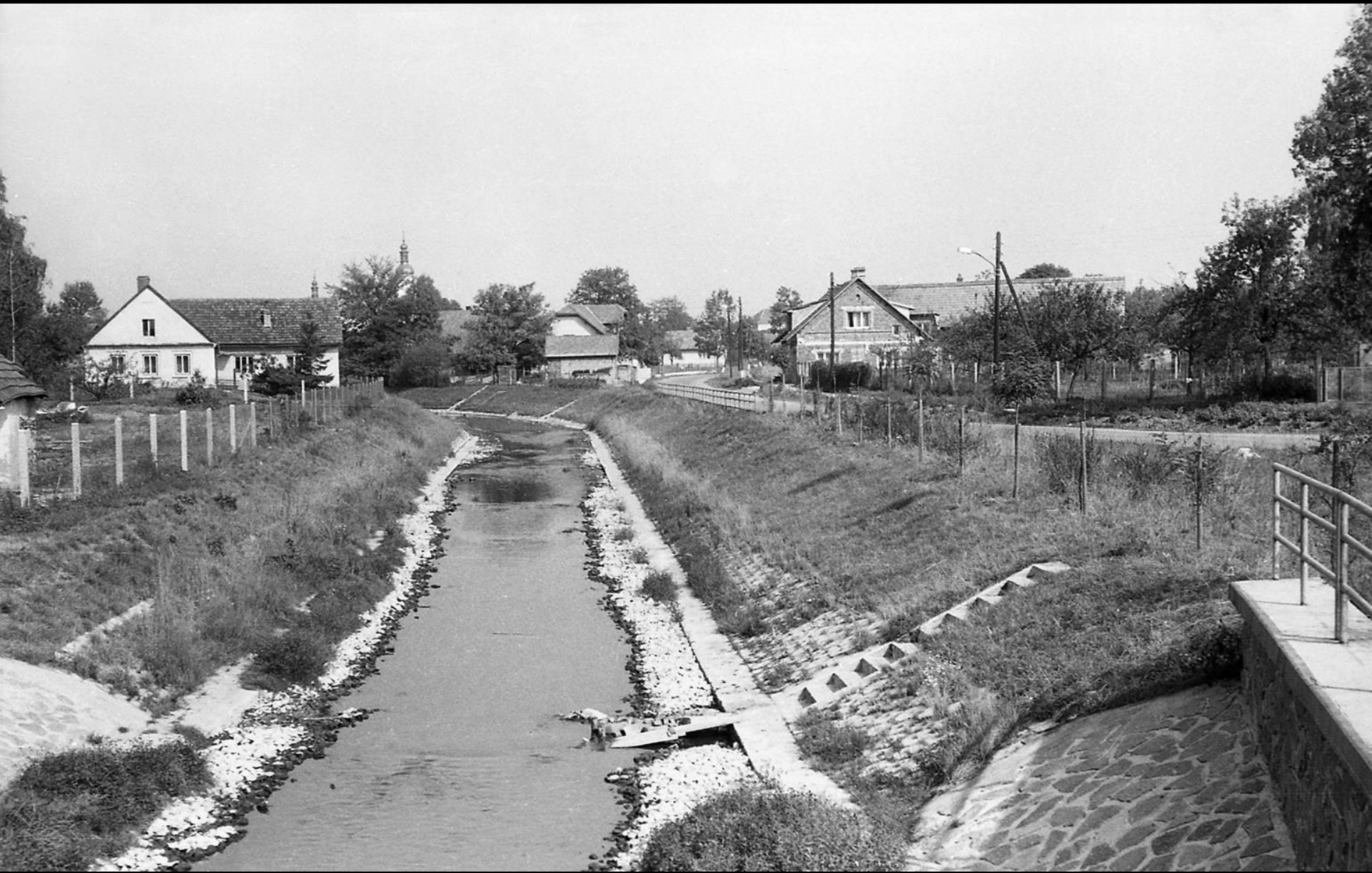
Dokončená regulace z mostu v Nerudově ulici
