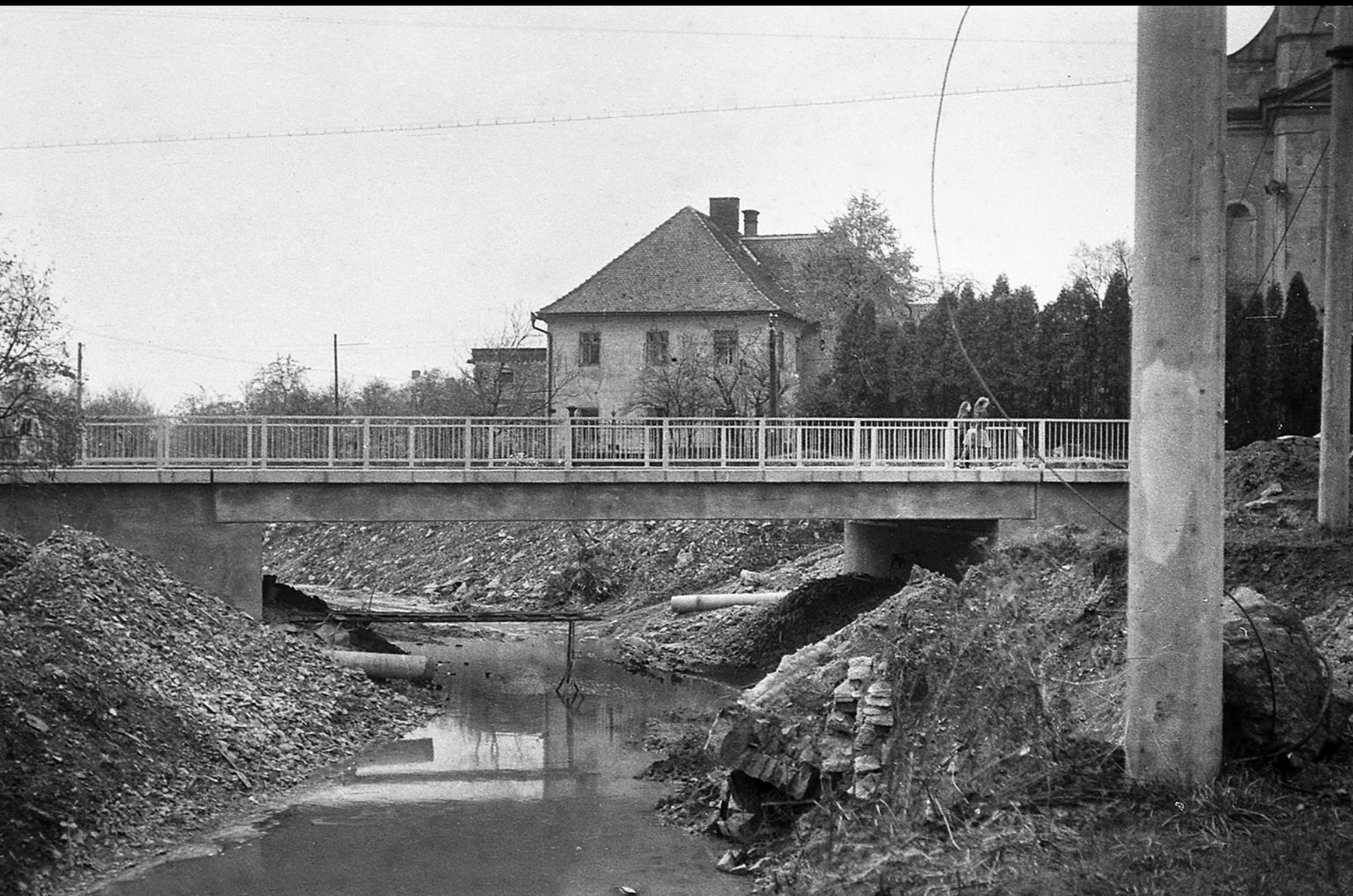
V popředí pozůstatky oblouku starého kamenného mostu
