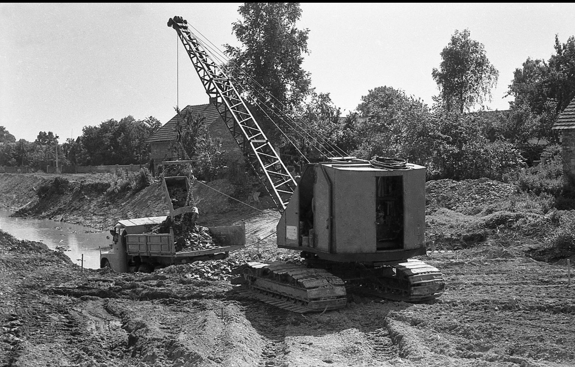
Foto dokumentující hloubku bagrování
