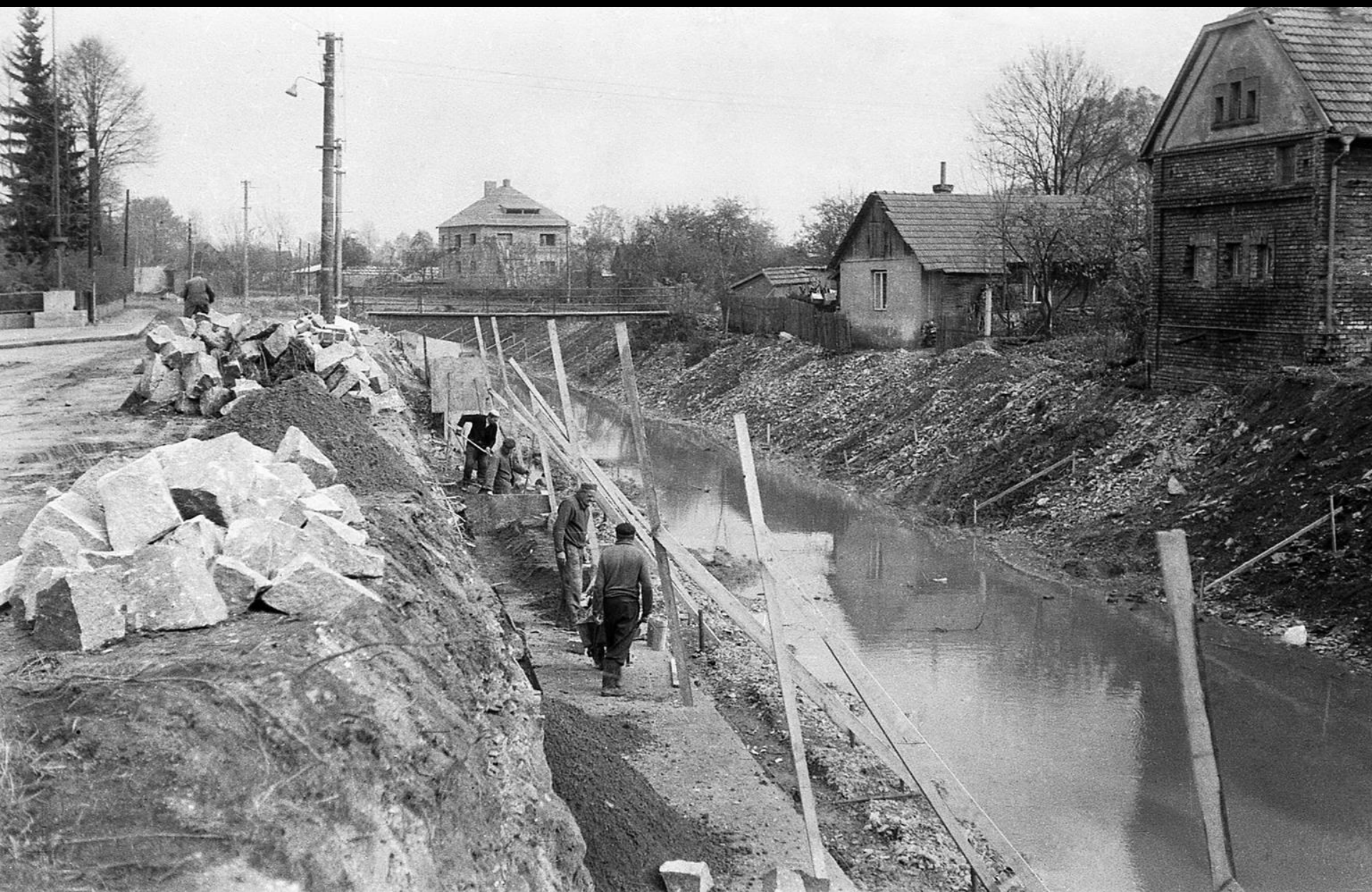
Stavba kamenné opěrné zdi
