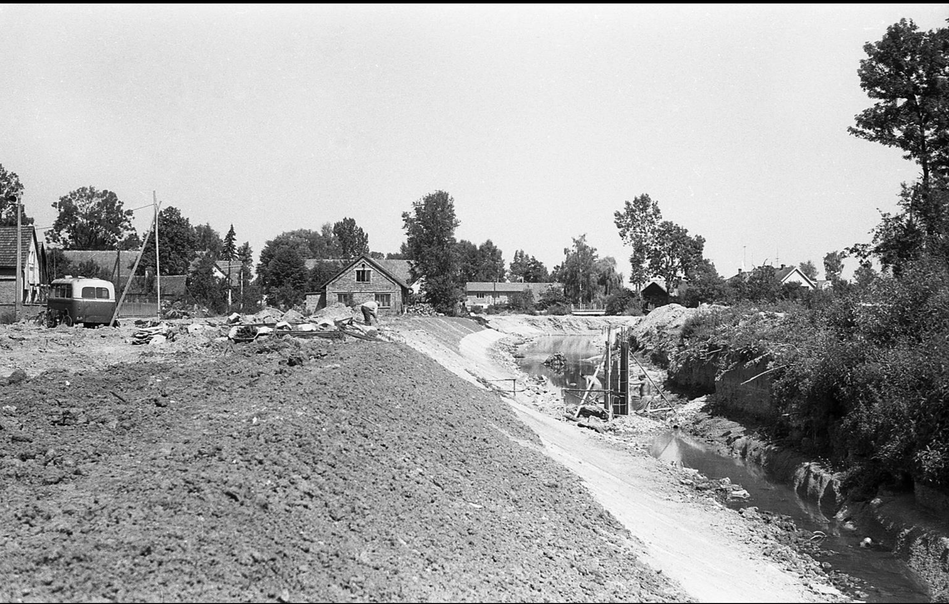
Dokončený pravý břeh, suchá stavba pilířů pro lávku
