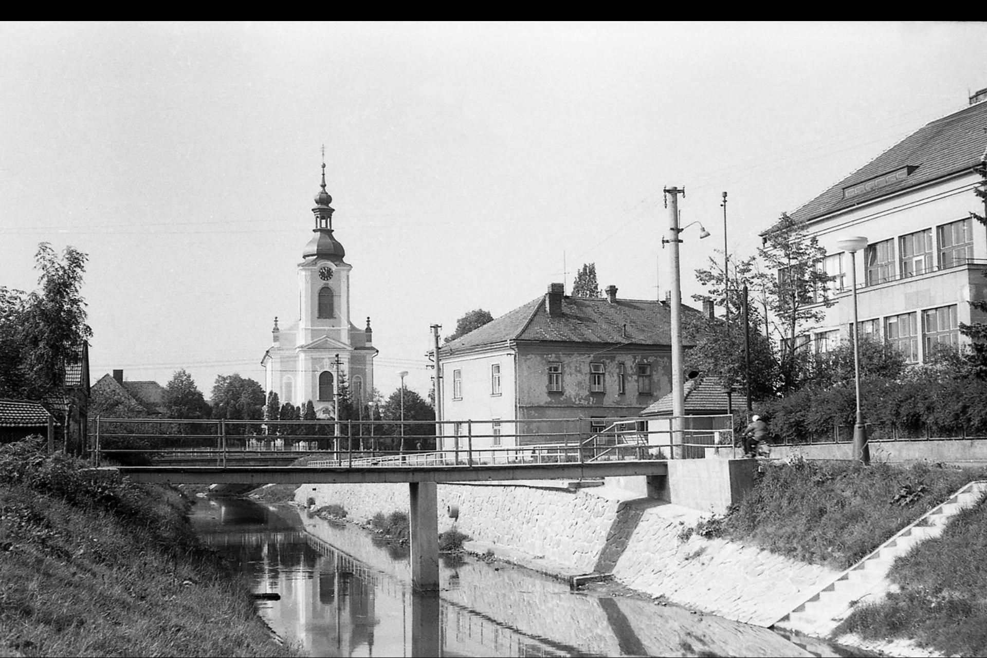
Dokončená regulace v centru obce
