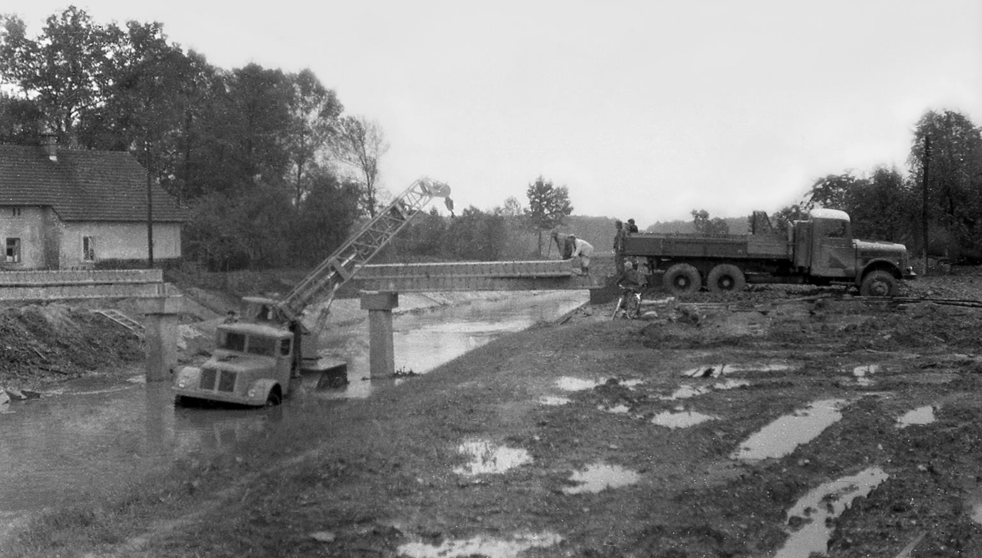
Instalace nosníků lávky za normálního toku řeky
