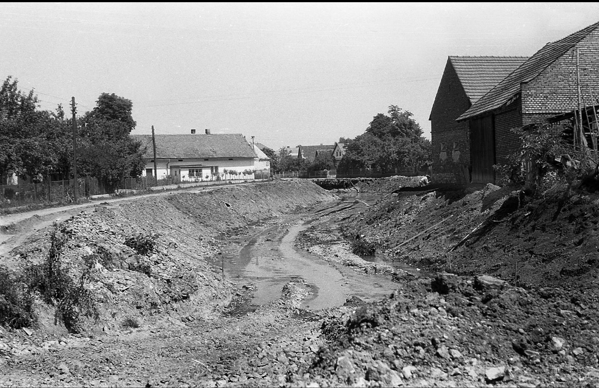
Vybagrované koryto u Jindrových v ulici Na nábreží
