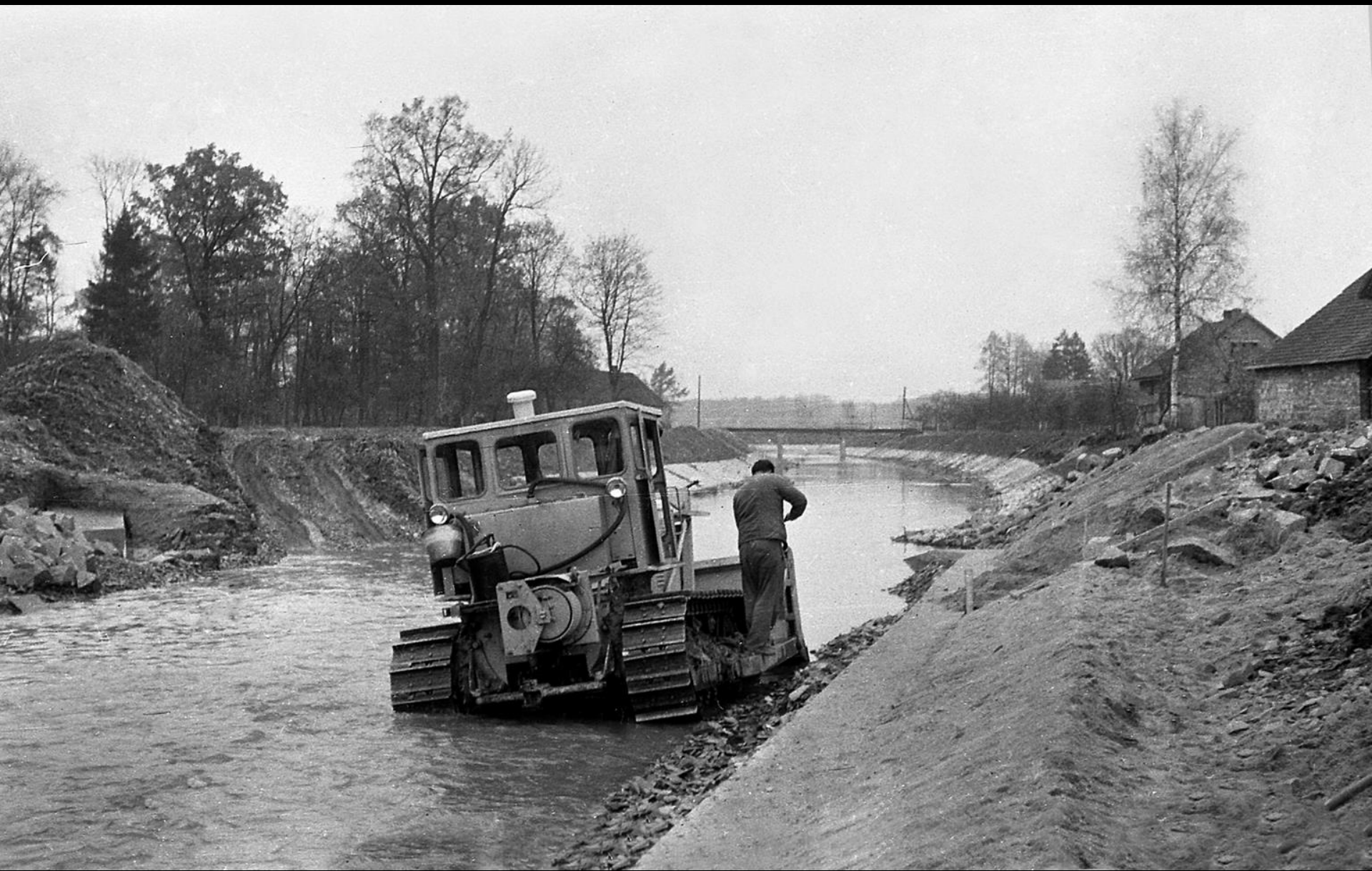
Zprovozněné hlavní koryto, provizorní zasypáno
