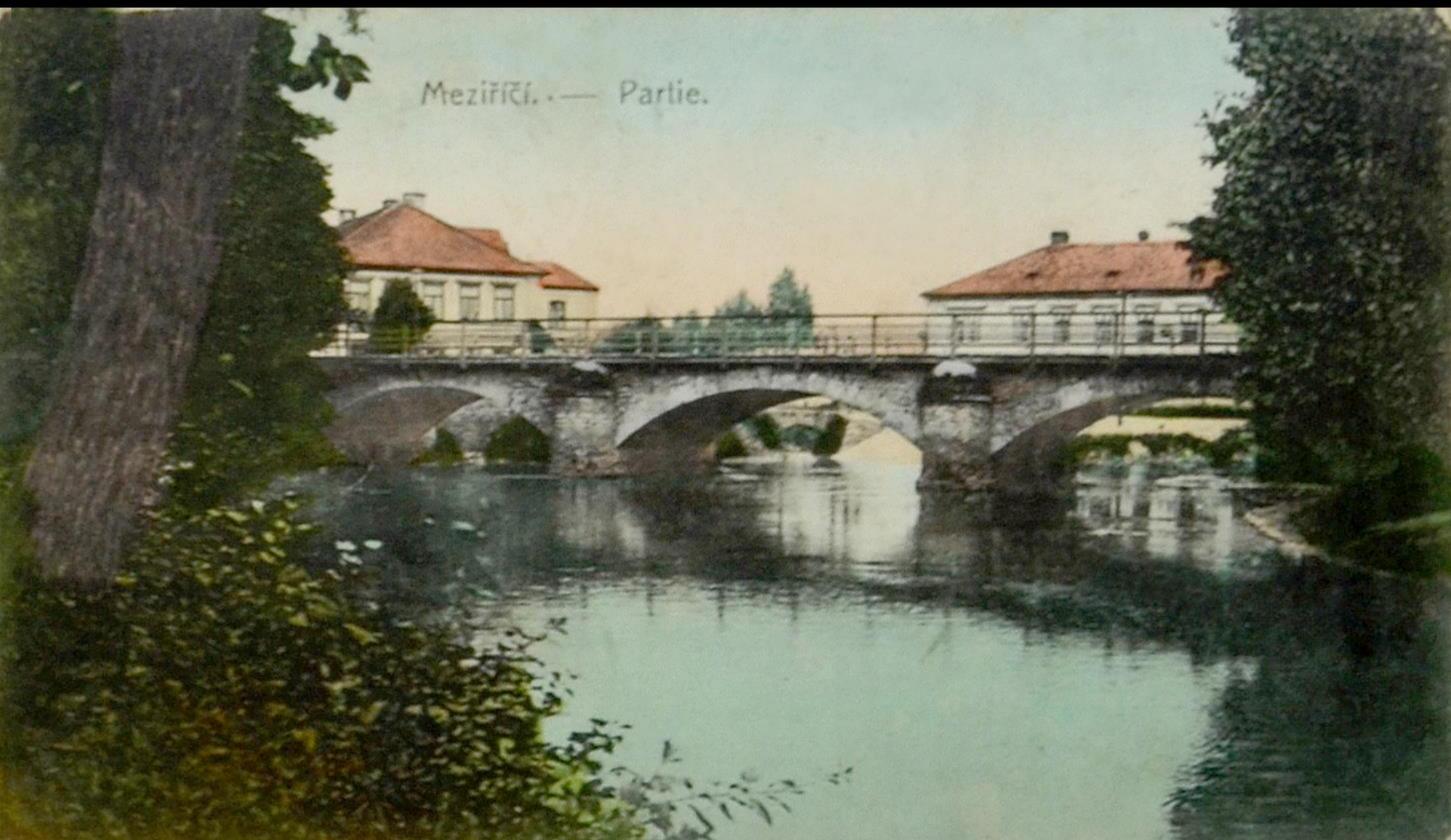
Kamenný most přes Dědinu pod kostelem
