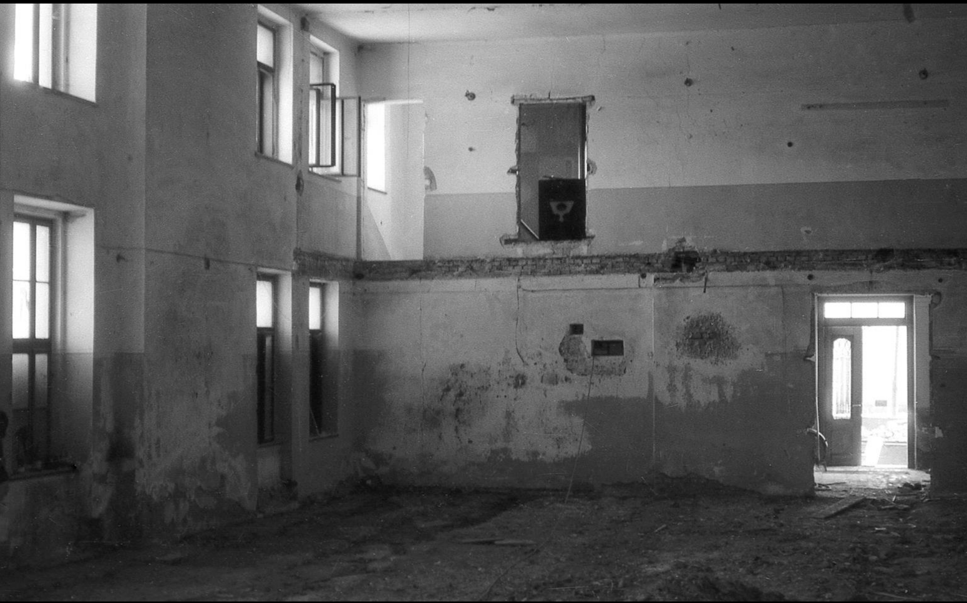
Bývalý taneční sál sloužil jako skladiště obilí
