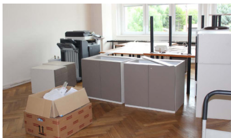
Montáž nábytku ve sborovně
