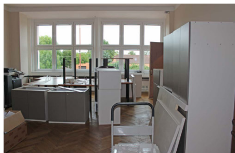
Rekonstrukce sborovny - nový nábytek
