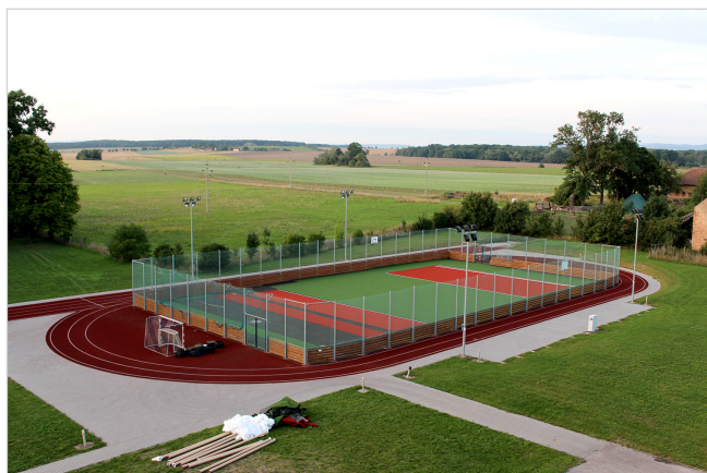
Nový povrch na sportovním hřišti za školou
