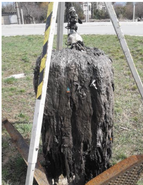
Takto zanesená česla koše z čerpací stanice musejí pracovníci Technických služeb pravidelně čistit
