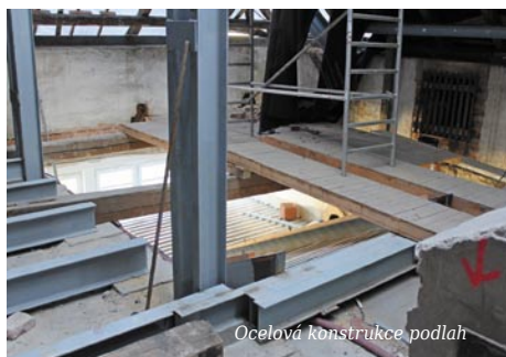
Ocelová konstrukce podlah
