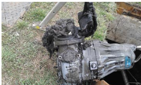
Ucpaný rotor čerpadla obtížně rozložitelnými vlhčenými ubrousky
