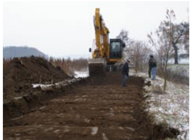
Skrývka přístupové cesty
